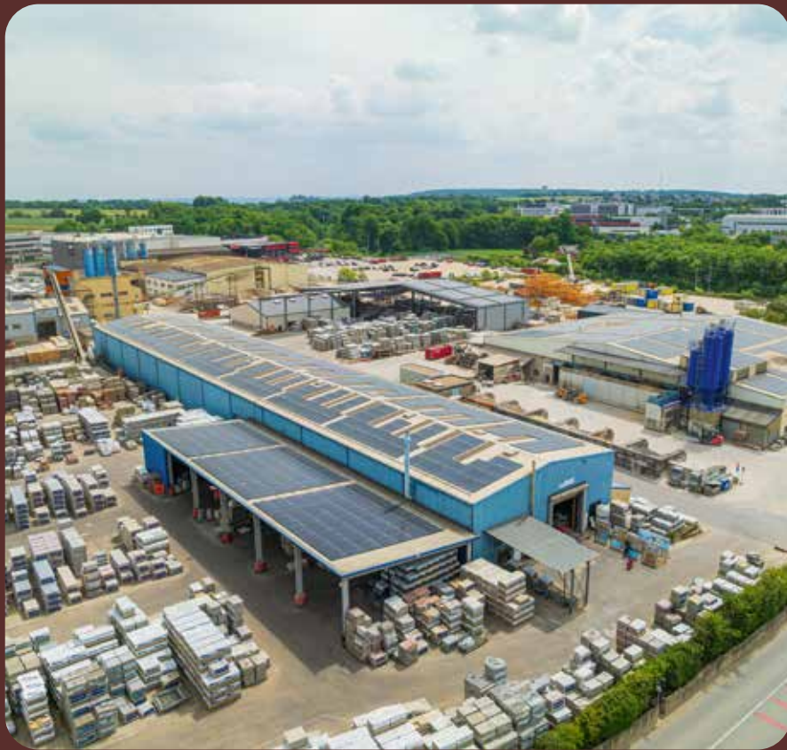
Paul Wagner & Fils S.A., PV Contern
